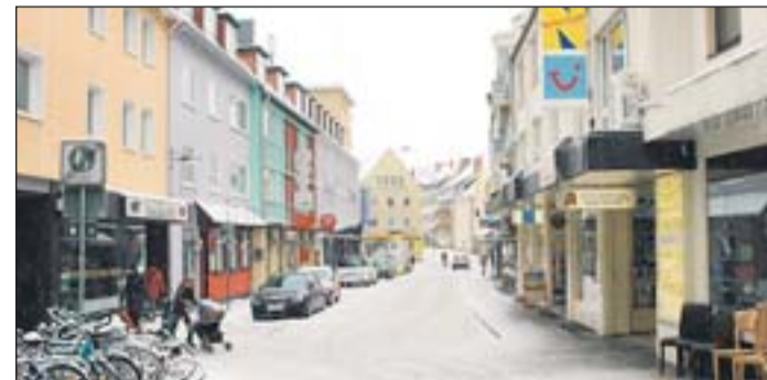
Der Kurze Hagen wird demnächst ausgebaut. Die Stadt informiert am kommenden Mittwoch die Anlieger über die geplanten Maßnahmen. Foto: Andreas Mayen
